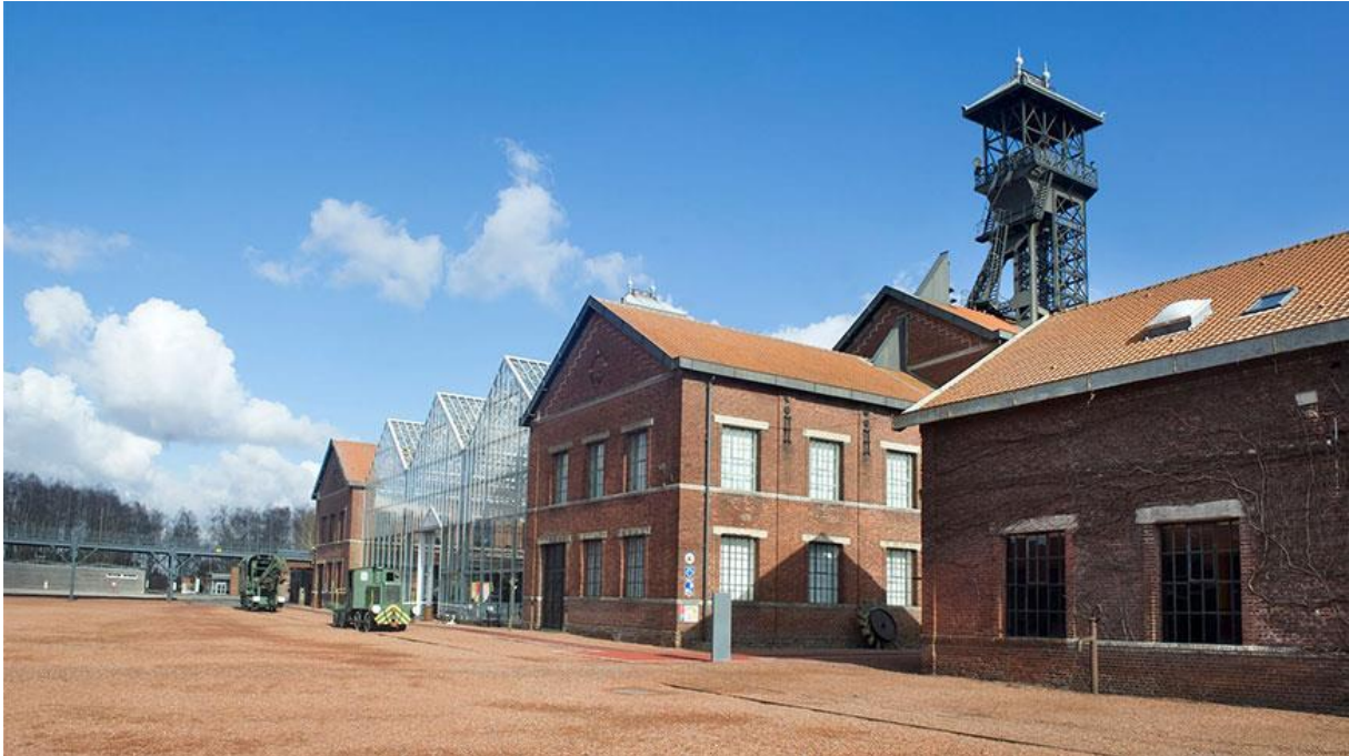
Vue générale du site | © Centre Historique minier 9
